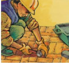
Para colocar los adoquines dentro de su lugar se puede utilizar un martillo de goma (figura 7), que no causará ningún daño sobre los euroadoquines .
