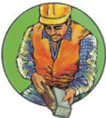
Posteriormente , se extraen los euroadoquines (sin trabazón), con una herramienta adecuada. Este modo de operar se prolonga hasta que un área de adoquines ha sido quitada, al menos dos filas más allá de la zona a excavar.
