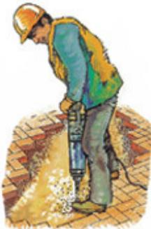
Así, se llevará a cabo una compactación en capas de no más de 15 cm de espesor, siendo cada capa completamente compactada con un plato o vibrador neumático (figura 5). Los materiales existentes en el pavimento deberían ser reemplazados con profundidades equivalentes del nuevo material.
