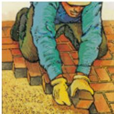
Para proceder a la rehabilitación de la superficie del pavimento, se quita cualquier arena contaminada y se añade material fresco, aproximadamente en las dos terceras partes del espesor completo, para posteriormente compactar totalmente con un plato vibrador al nivel que está por debajo del área, arena adicional que se nivelará convenientemente, finalizando con la recolocación de los adoquines originales tan ajustadamente como sea posible. (Figura 6).
