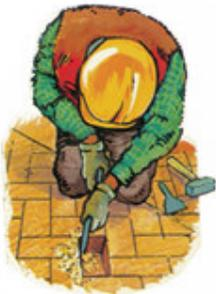
Una vez que el primer adoquín ha sido retirado (figura 2), se sacan los siguientes usando una pata de cabra o herramienta adecuada. Para levantar los adoquines adyacentes a la zona abierta, puede resultar aconsejable pasar sobre su superficie un plato vibrador que ayudaría a romper la trabazón existente entre los mismos.
